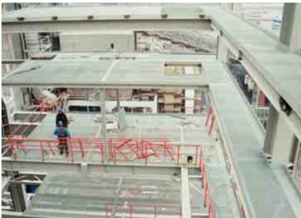
Чертеж 1 Използване на контактно заварени решетъчни скари със стандартна широчина и завършваща решетъчна скара с производствена широчина.
